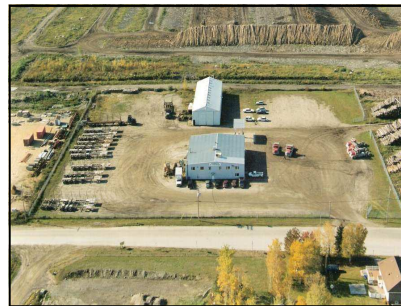
Depuis 1984, la Coopérative œuvre dans le transport et le chargement de billots (photo: Coopérative de camionnage de St-Félicien)
